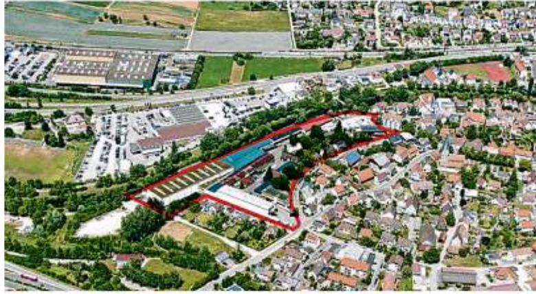
In Faurndau wurde jetzt das Vorhaben erläutert: Es sollen Wohn- und Gewerbeflächen entstehen.
